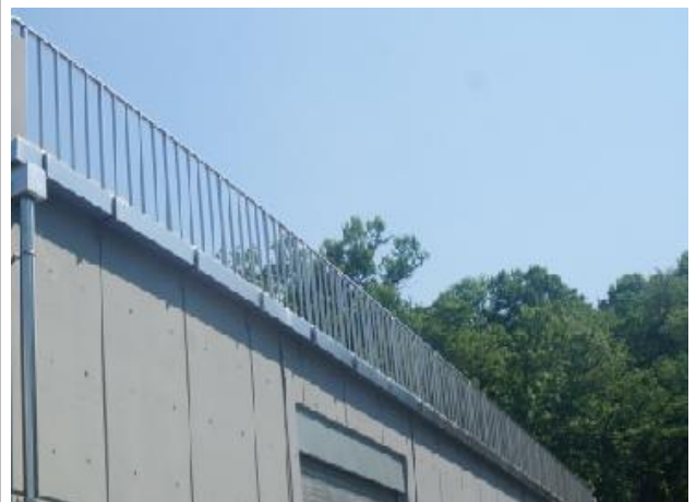
유입밸브실 상부 안전난간 상태양호
