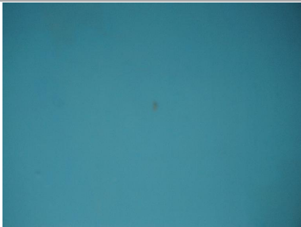
배수지1지 상부슬래브 녹
