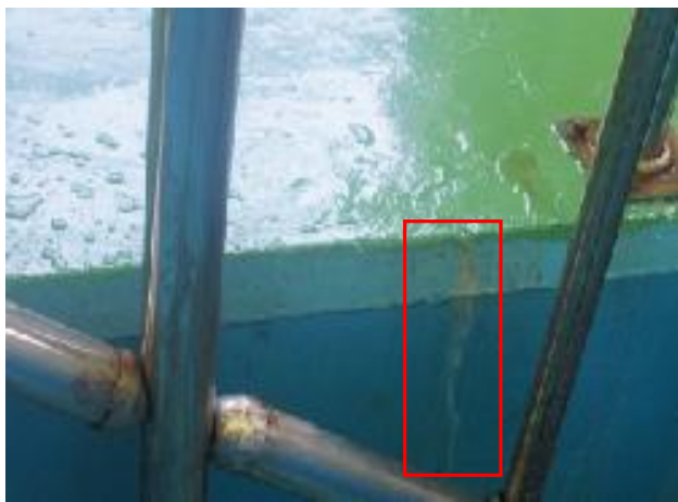
1지 계단실 바닥슬래브 측면 백태
