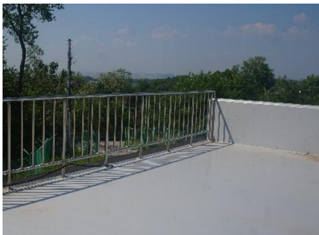
유입밸브실 상부 안전난간 상태양호
