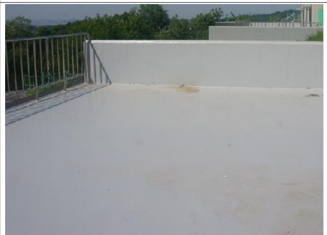
유입밸브실 외부 상부[방수층 재시공 완료]
