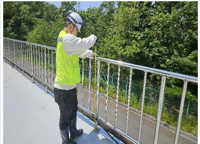
유입밸브실 상부 안전난간 상태양호
