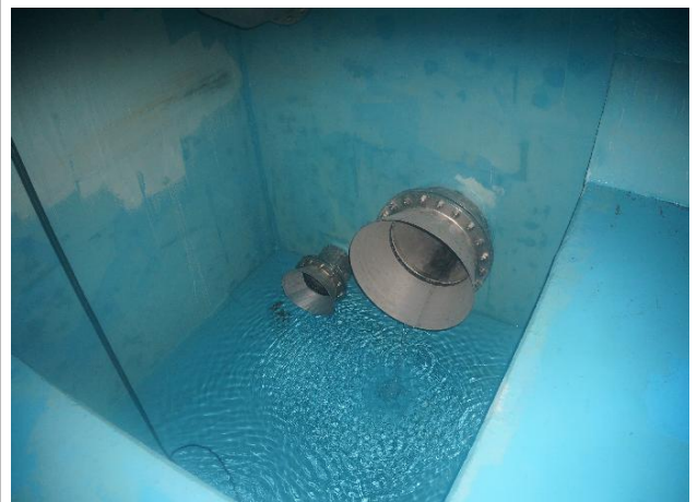
배수지 1지 유출관 및 퇴수관 상태양호
