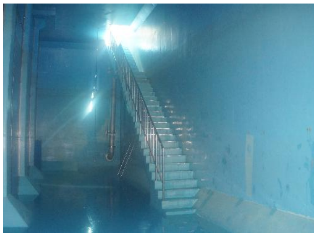
배수지 내부 안전난간 상태양호
