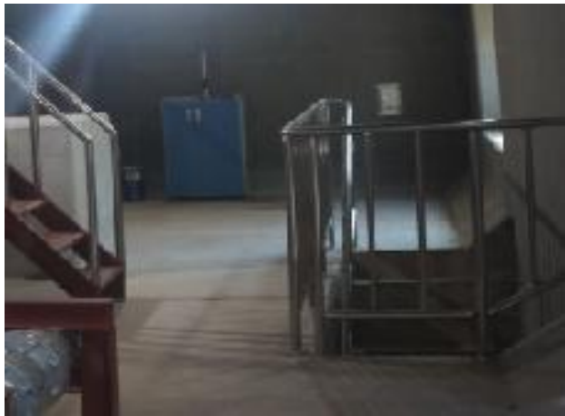
유입밸브실 내부 안전난간 상태양호
