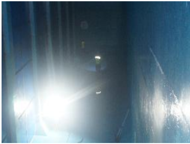
배수지 청소 시 외관조사
