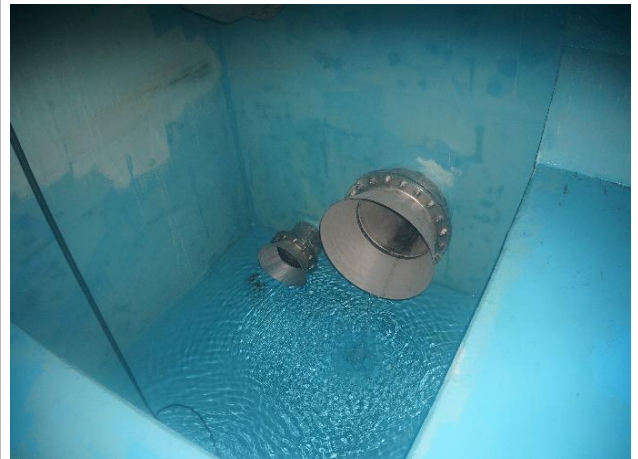
배수지 1지 유출관 및 퇴수관 상태양호
