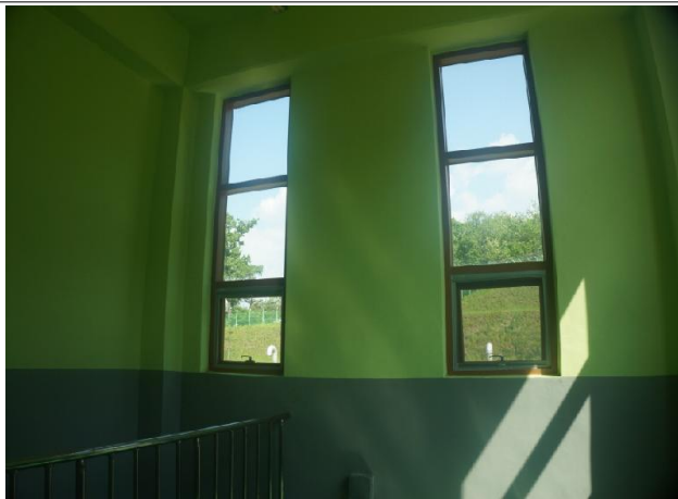
2지 계단실 내부 벽체, 기둥 상태양호
