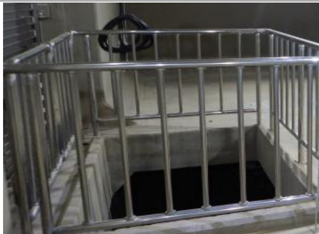
유입밸브실 장비투입구 안전난간 상태양호
