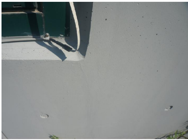
유입밸브실 외부벽체[페인트 보수완료]
