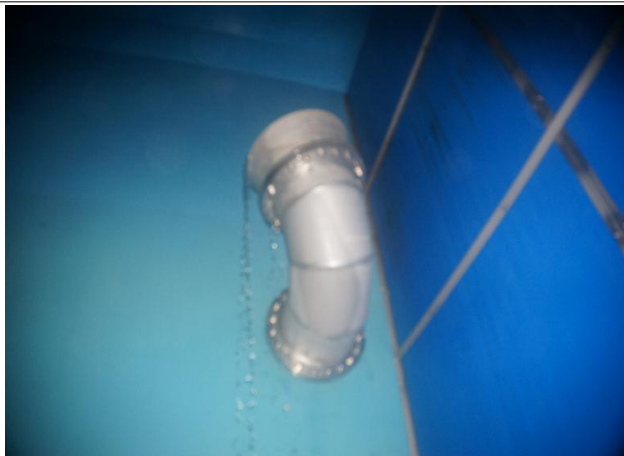
배수지 2지 유입관 상태양호
