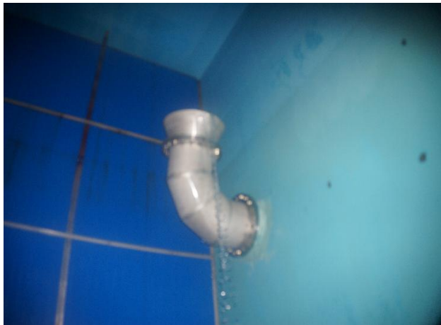
배수지 1지 유입관 상태양호
